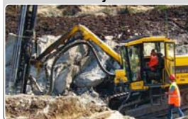
Anläggningsarbeten ovan jord
